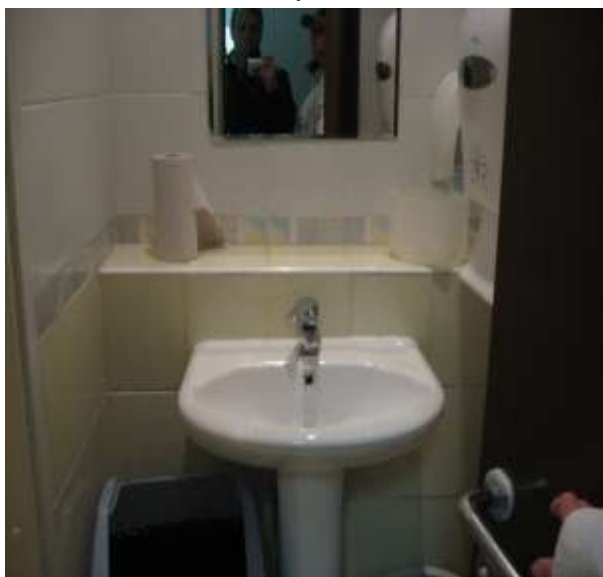
Табл.47. Помещение санузла.
