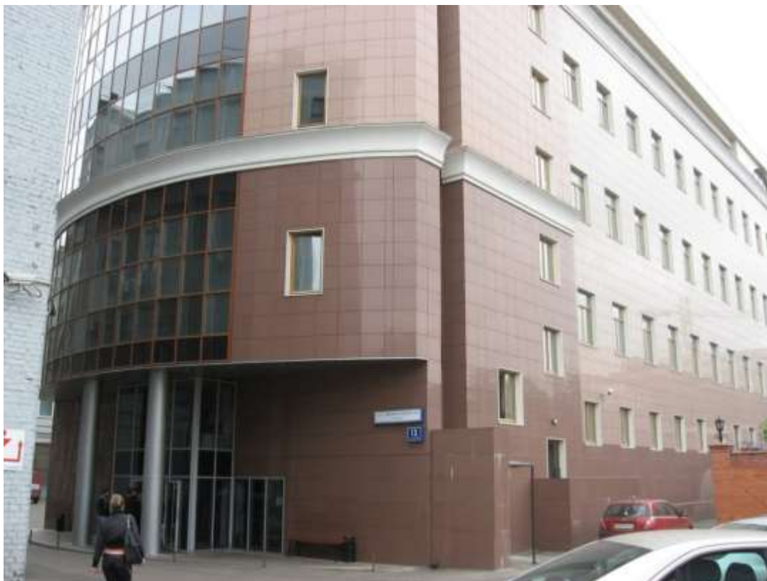
Общий вид фасадов здания
