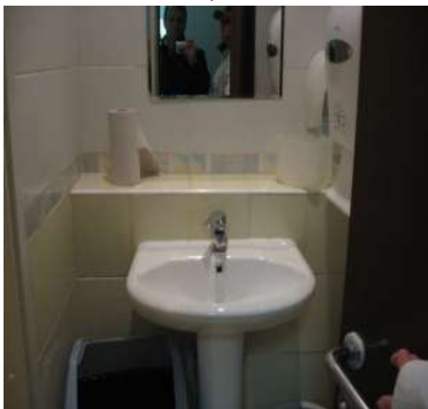
Табл.49. Помещение санузла.
