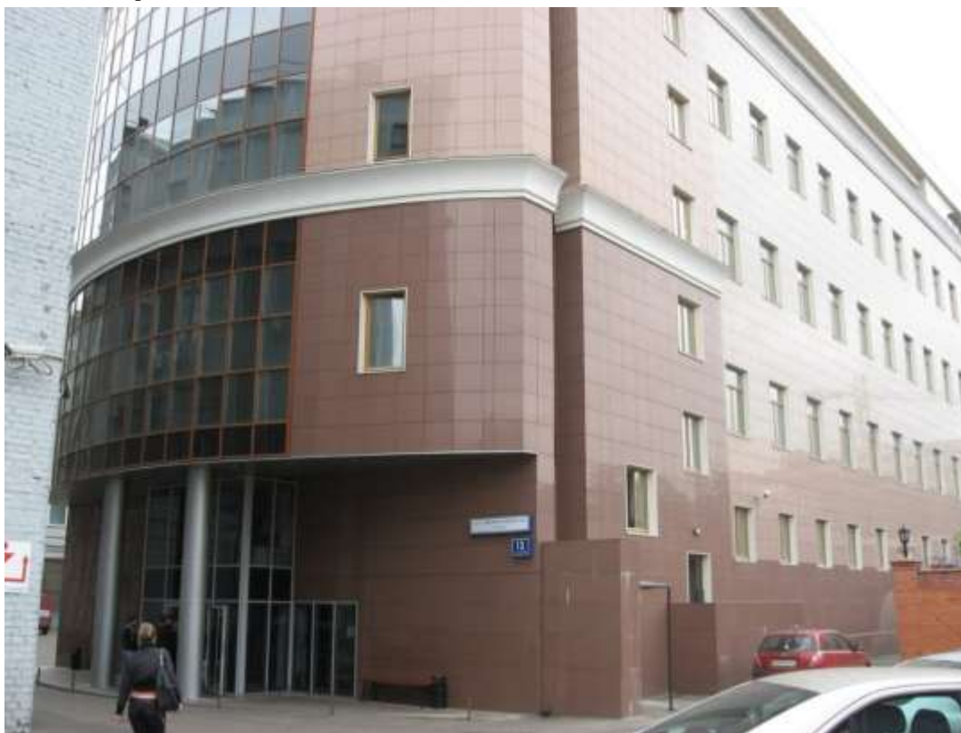
Общий вид фасадов здания
